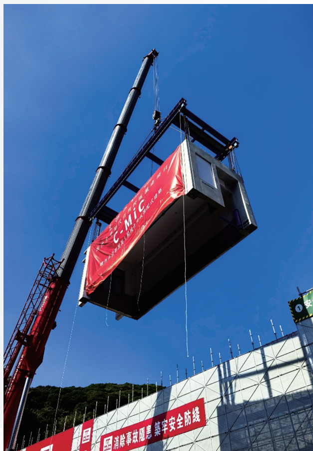
■ MiC module hoisting
